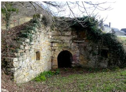
La fabrication de la chaux nécessitait une température proche de 1000°C. Une ouverture à la base permettait d'alimenter en bois ; au sommet, une autre ouverture servait à introduire les pierres.
